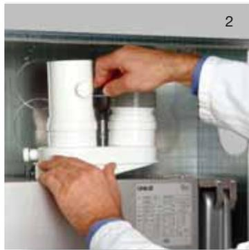
2 Disposizione sistema di scarico
